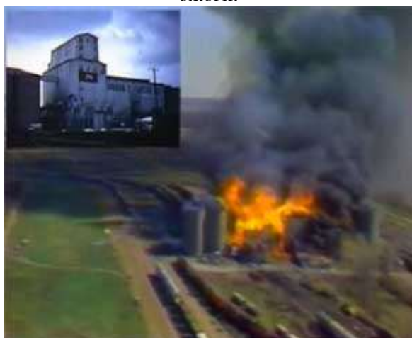
Фото 5. Полностью разрушен в результате взрыва зерновой пыли и пожара элеватор
