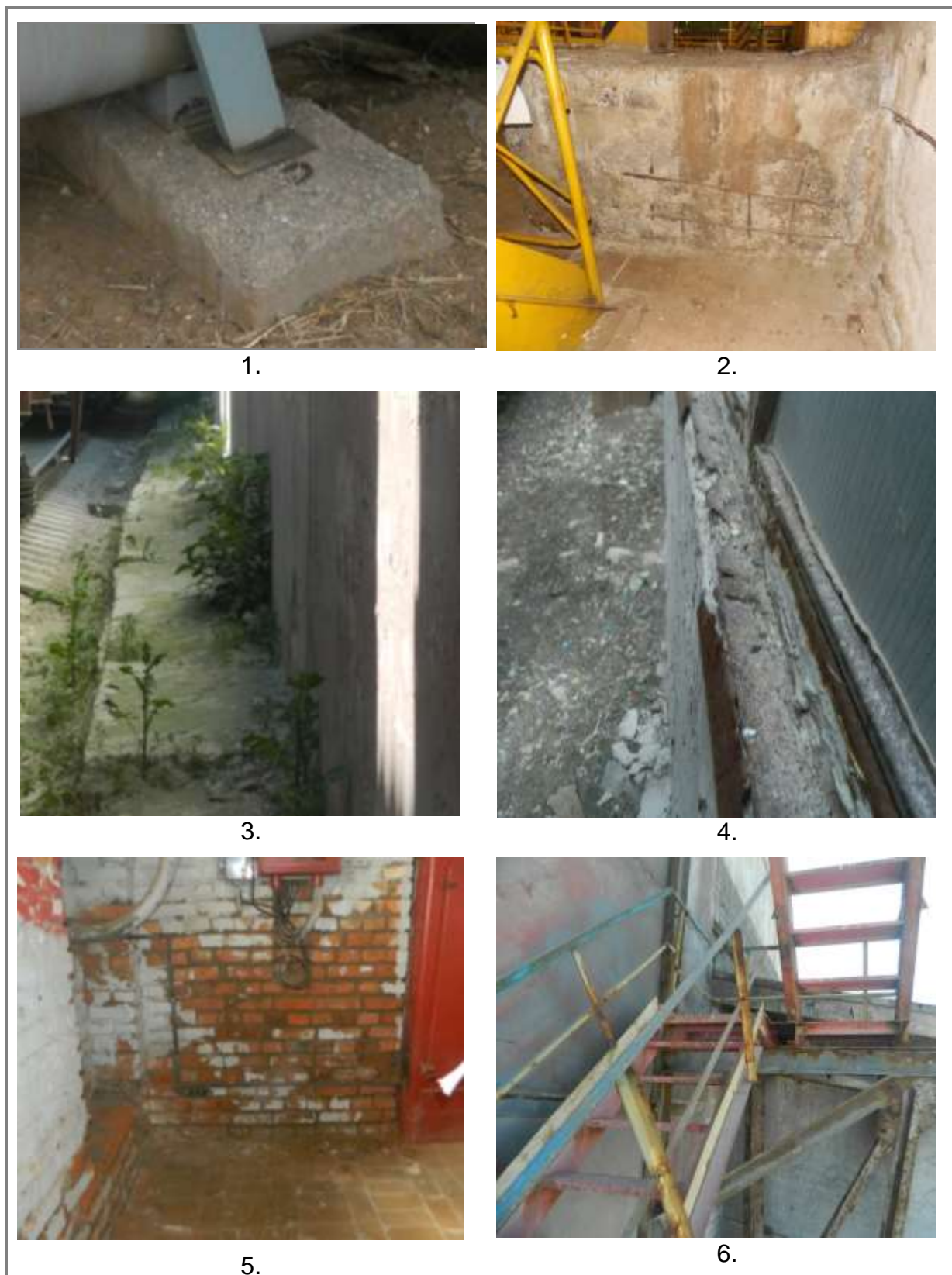
Рис. 2. Распространенные дефекты и повреждения: 1-6.
