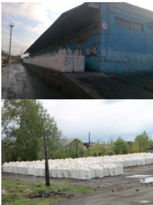
Рис. 4. Типичные нарушение хранения селитры в таре
