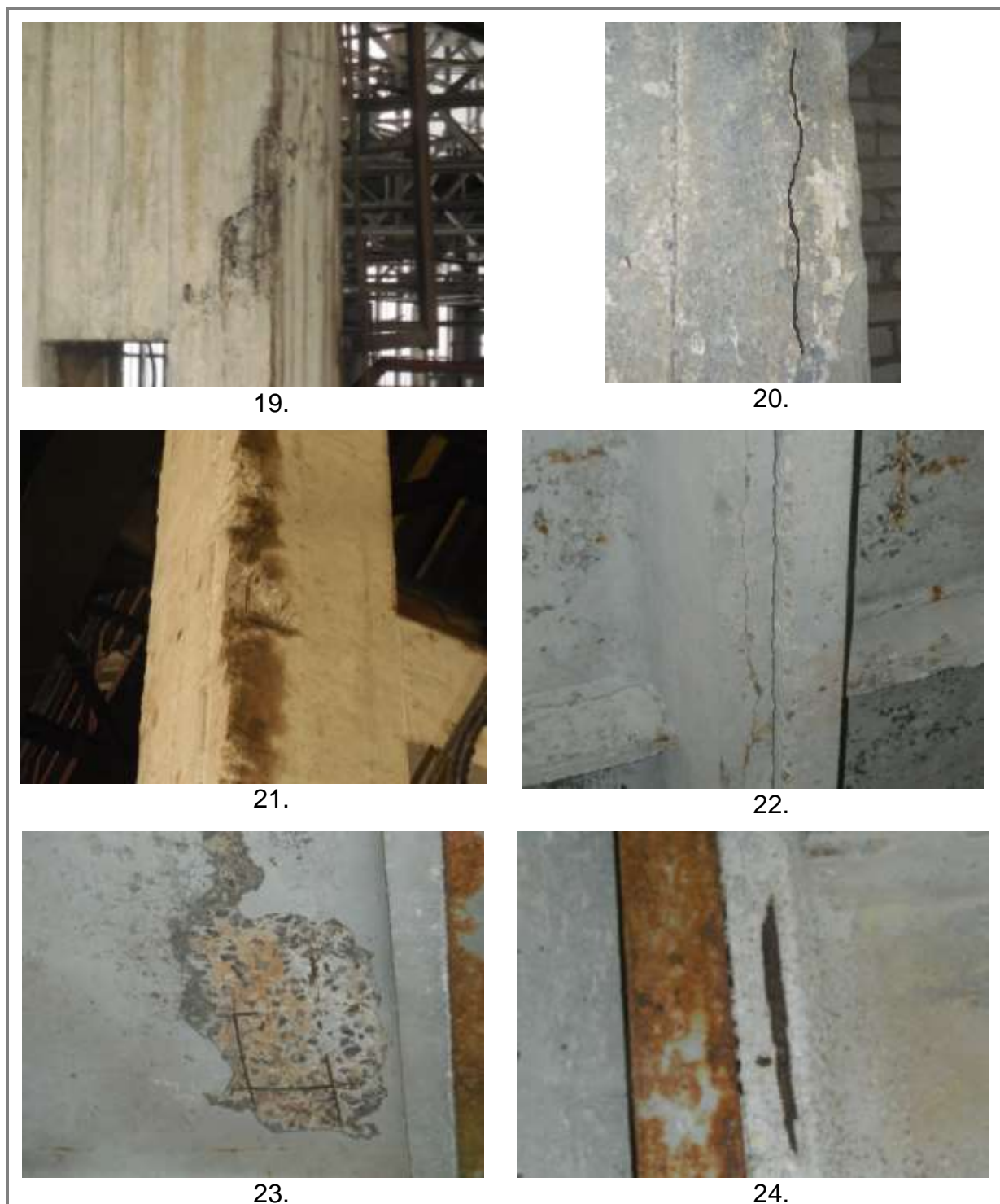
Рис. 2. Распространенные дефекты и повреждения: 19-24.
