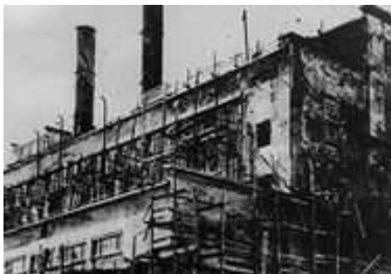
Фото 1. Обрушение металлоконструкций цеха в Комсомольске на Амуре, 1960 г.
