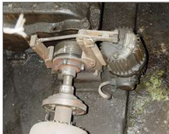
Фото 3. Отсутствие штатных деталей крепления.
