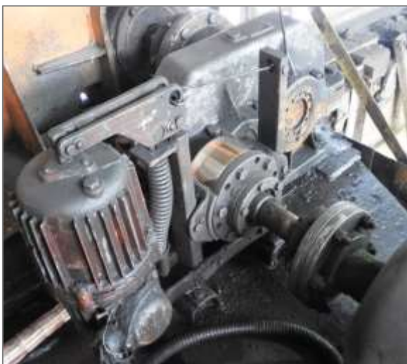
Фото 2. Отсутствие штатных деталей (тяги тормоза).
