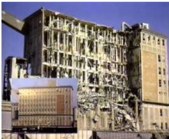
Фото 4. Эта восьмизэтажная мельница в Канзас-сити, США, была полностью разрушена также в результате пылевого взрыва. К счастью, обошлось без жертв и только 5 сотрудников получили тяжелые ожоги.
