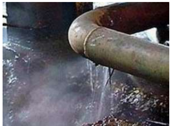
Фото 2. Авария на теплотрассе в Саратове, ул. Навашина. Поток горячей воды.
