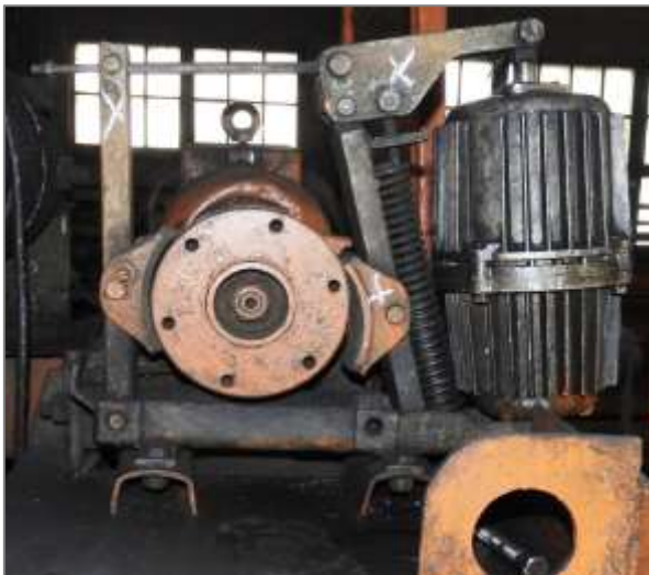
Фото 1. Отсутствие штатных деталей крепления гидротолкателя, рычагов (стоек).
