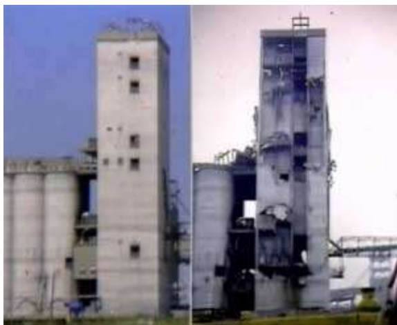
Фото 9. Обширный пылевой взрыв зернового элеватора в городе Галвестон, штат Техас, США, - 22 человека ранено, 18 погибло.
