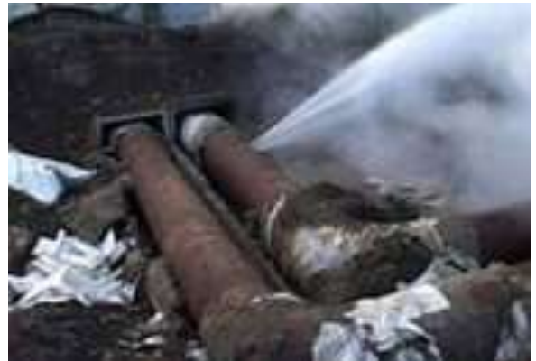
Фото 1. Авария на теплотрассе в Туле оставила в городе 38 домов без отопления.
