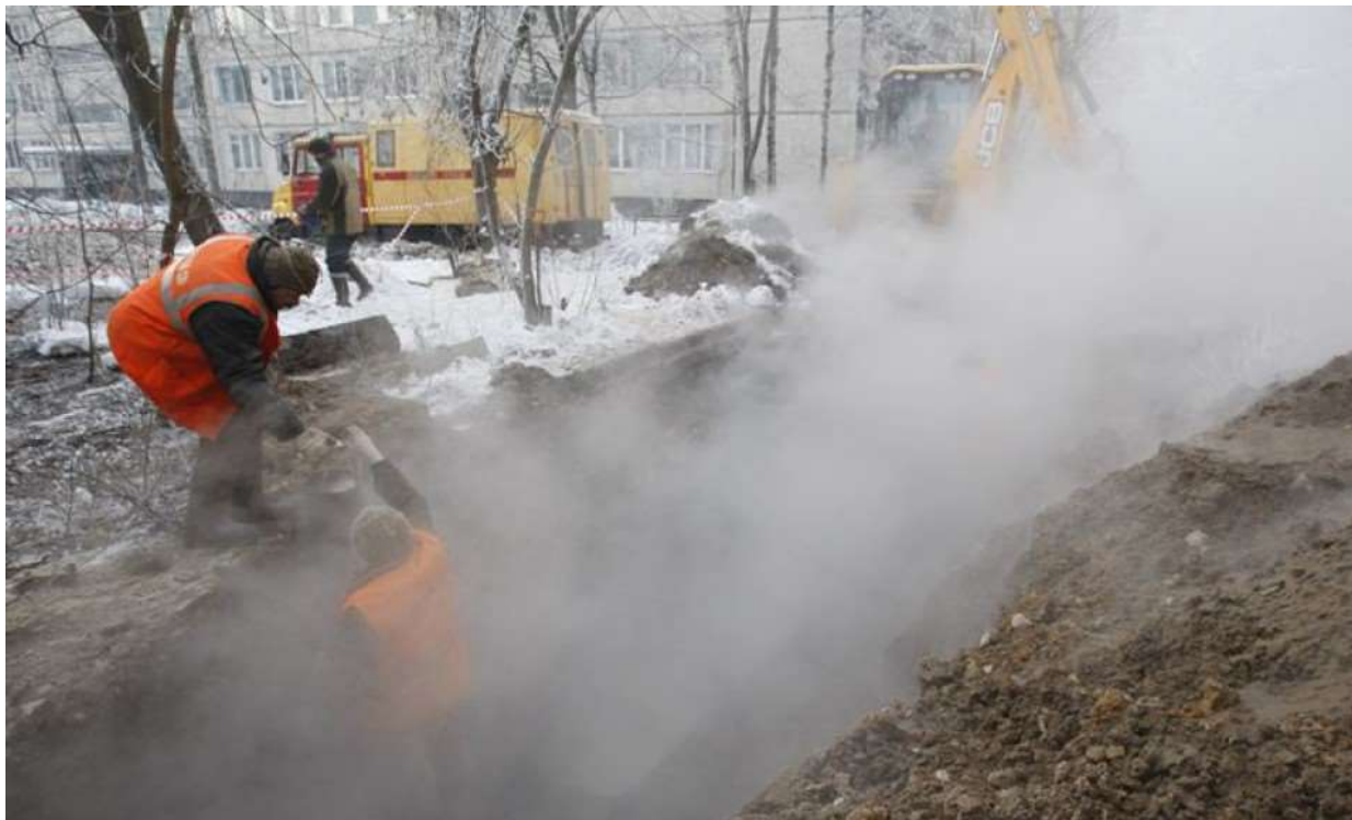
Фото 3. Аварии на теплотрассах в Санкт-Петербурге – частое явление.
