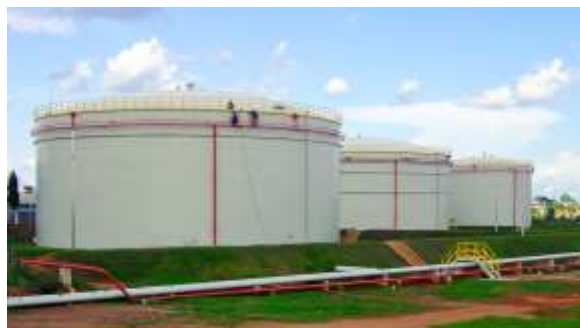
Рис. 1. Резервуар вертикальный стальной
