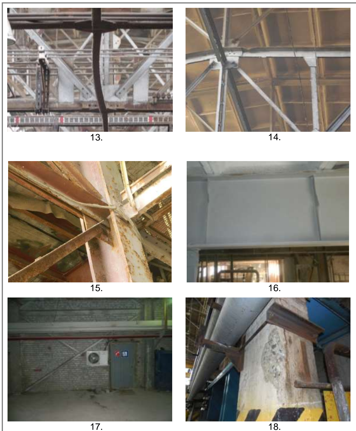
Рис. 2. Распространенные дефекты и повреждения: 13-18.
