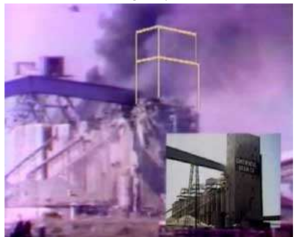
Фото 2. Взрыв элеватора в Новом Орлеане, США. Погибло 36, ранено 9 человек. Верхние этажи рабочей башни полностью разрушены.
