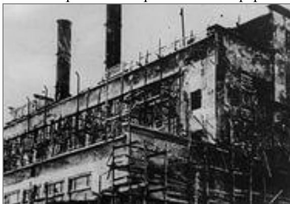
Обрушение металлоконструкций цеха в Комсомольске на Амуре, 1960г., images.yandex.ru
