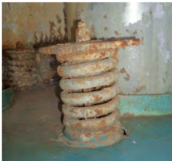
Рис. 4. ОПС трубопроводов, установленная в местах повышенной влажности имеет коррозионный износ резьбовых соединений, вследствие отсутствия антикоррозионного покрытия.
