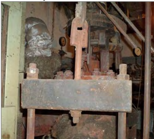
Рис. 3. Отсутствие контргаек в элементах пружинных блоков, опорных металлоконструкциях или узлах крепления.
