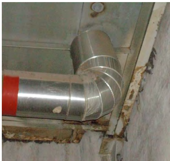
Рис. 5. Заземление трубопровода в местах прохода трубопроводов через стены, перекрытия и площадки обслуживания из-за недостаточных размеров отверстий в них.
