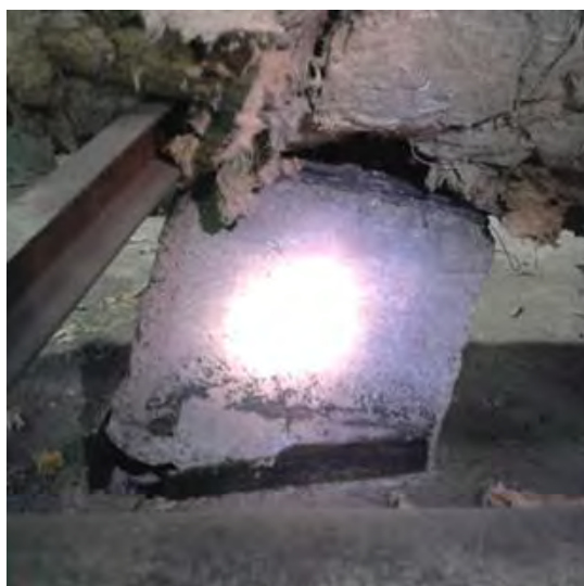
Рис. 9. Повреждения основания неподвижной опоры вследствие нерасчетных эксплуатационных усилий.
