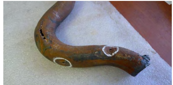
Рис. 5. Внешний вид повреждения трубы потолочного пароперегревателя котла №9.
