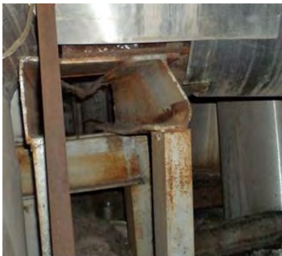
Рис. 6. Деформация основания опоры, вследствие установки непроектных несущих конструкций.
