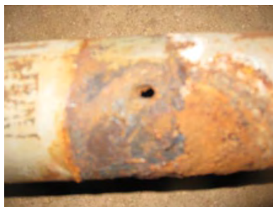
Фото 5. Сквозная коррозия участка трубопровода.
