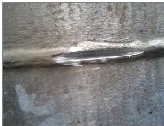
Фото 3. Пора в сварном шве.
