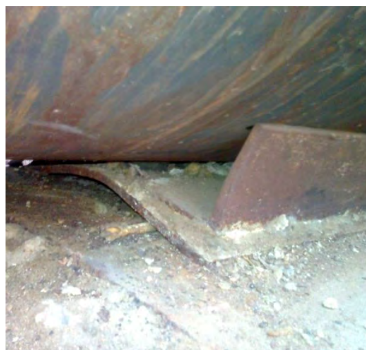
Рис. 12. установлены непроектные комплектующие скользящей опоры. Отсутствует сварной шов приварки скользящей площадки к телу трубы.
