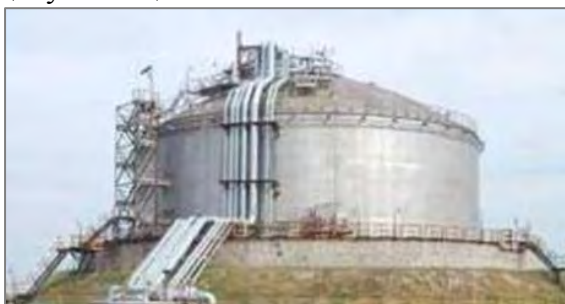
Фото 1. Общий вид изотермического хранилища аммиака.
