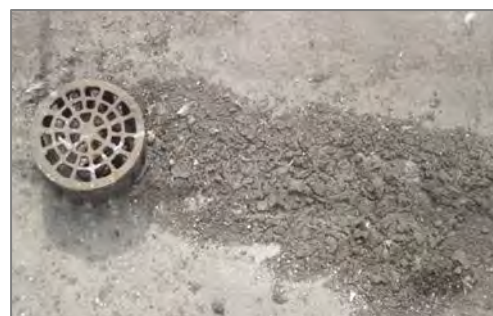
Рис. 9. Наличие скоплений мусора в водоприёмных устройствах ливневой канализации
