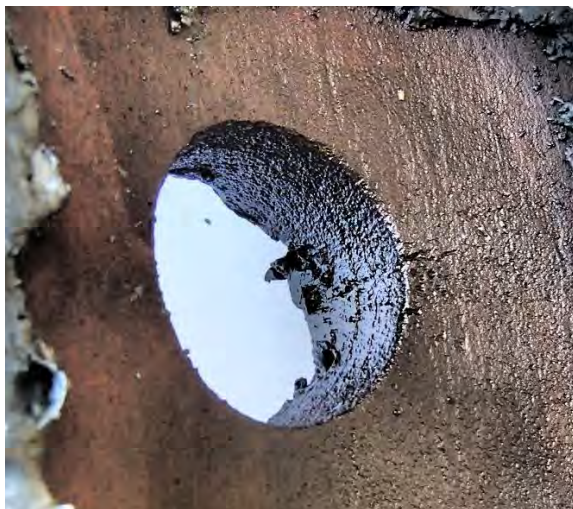
Рис. 3. Внешний вид радиального отверстия с трещинами на вырезке после замены коллектора.
