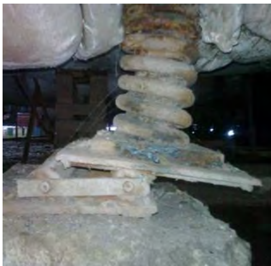
Рис. 10. Сход пружинного блока опоры с направляющих.
