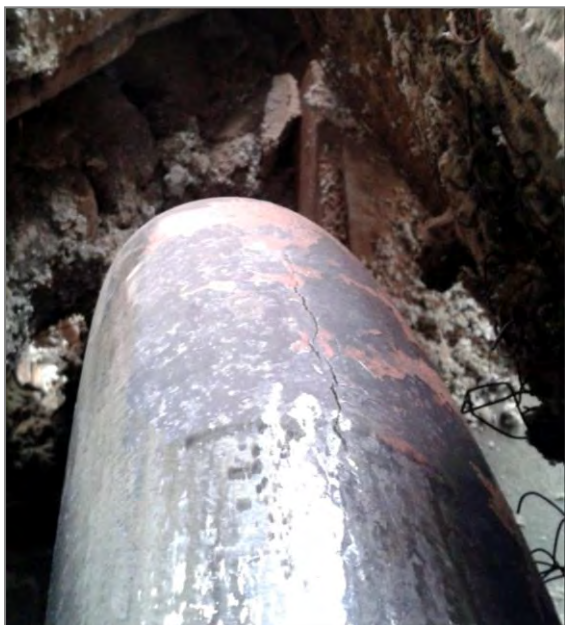
Рис.1. Трещина на растянутой части гiba пароперепускных труб котла ТГМ-84.
