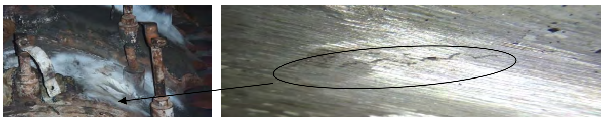
Рис.1. Трещина на наружной поверхности крышки корпуса турбины в месте радиусного перехода.
