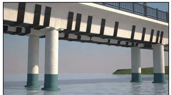
Рис. 2. Схема усиления железобетонной балки моста.
