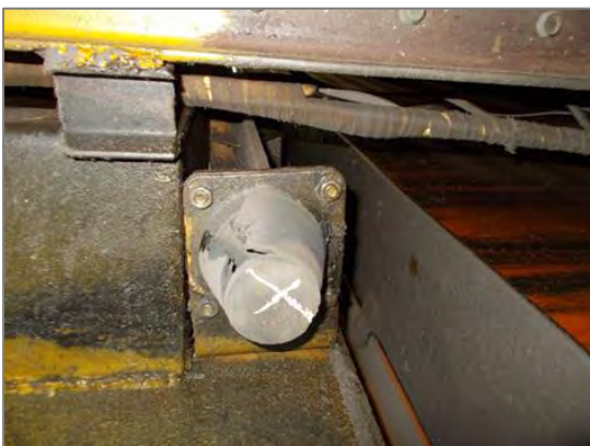
Фото 8. Неисправность буферного устройства.
