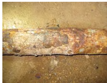
Фото 3, 4. Значительный коррозионный износ вследствие неблагоприятного воздействия окружающей среды.
