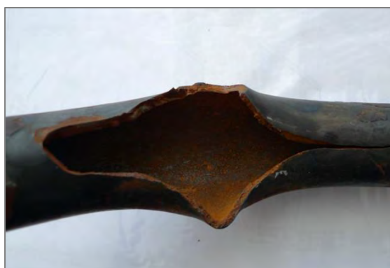
Рис. 1. Внешний вид повреждения трубы пароперегревателя IV ступени котла №8.
