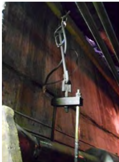
Рис. 8. Перекос центральной тяги в месте прохода через направляющие элементы, вследствие значительных горизонтальных усилий.
