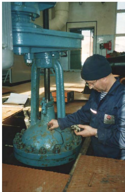
Рис. 2. Внешний вид задвижек насосных агрегатов НПС.
