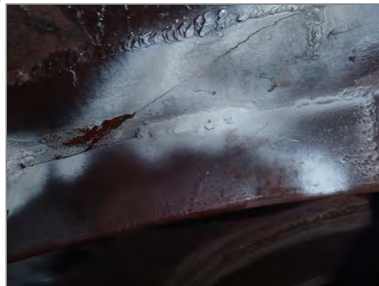
Рис. 4. Вид трещины с внутренней поверхности бака.
