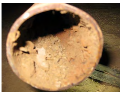
Фото 6. Внутренняя поверхность трубопровода.
