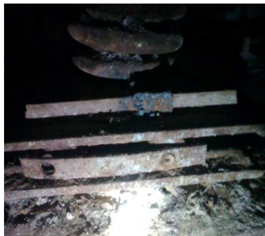
Рис. 11. Выпадение катка из каткового блока в следствии деформации угольника обоймы (катковой) пружинно-катковой опоры.
