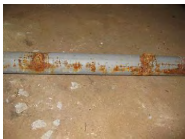
Фото 1, 2. Участки коррозии на наружной поверхности.
