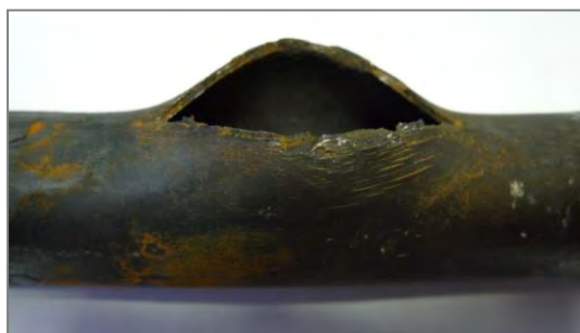
Рис. 3. Внешний вид повреждения трубы пароперегревателя III ступени котла №7.
