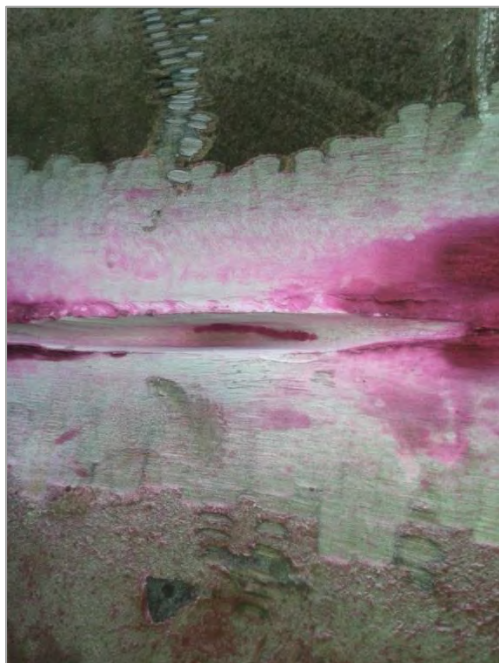
Фото 2. Визуализация дефекта сварного шва с помощью ЭШМ и применении метода ПВК
