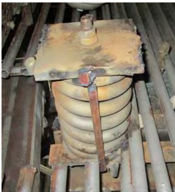
Рис. 7. Наличие на пружинных блоках не демонтированных монтажных стяжек или стяжек, у которых в сделана прорезь.
