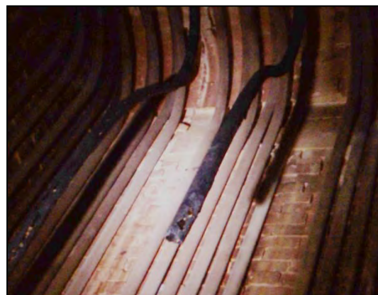
Рис. 1. Прогоревшие трубы фронтального экрана.
