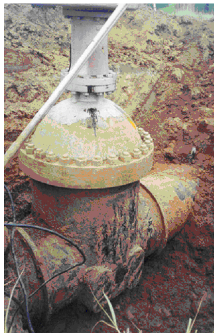
Рис. 1. Внешний вид линейной задвижки магистрального нефтепровода.
