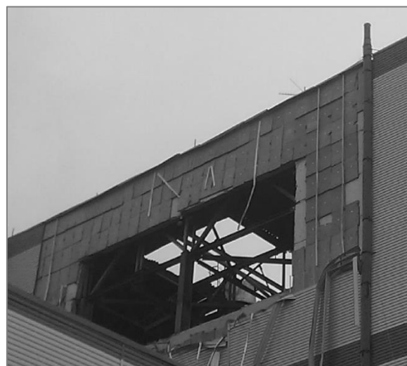
Рис.1. Последствия взрыва котельной в Нижегородской области в 2013г.
