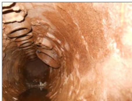
Фото 1. Накипь на внутренней стороне коллектора котла.
