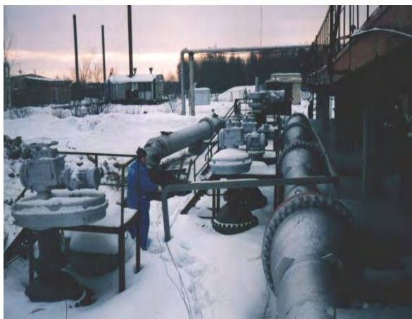
Рис. 3. Внешний вид задвижек коллектора НПС.
