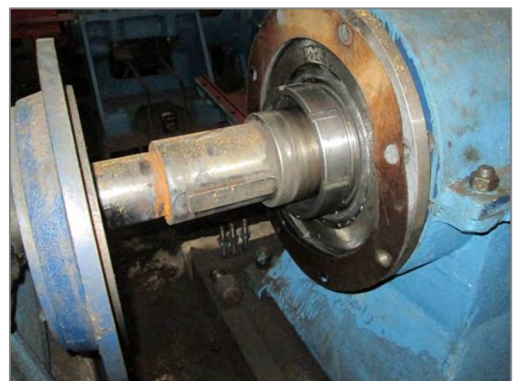
Рис. 2. Задняя часть насоса (со стороны электродвигателя). Крышка смещена.
