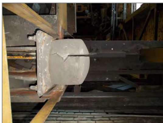
Фото 9. Неисправность буферного устройства.
