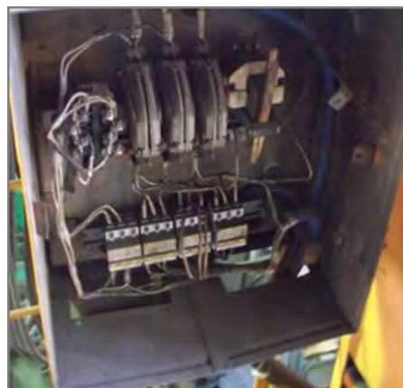
Фото 11. Неисправность главного контактора цепи управления в защитной панели крана.
