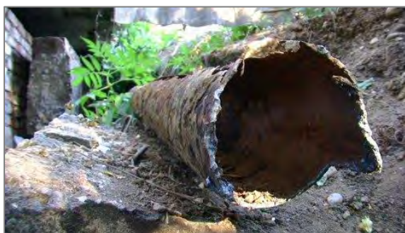
Фото 1. Поврежденный коррозией участок теплосети.
