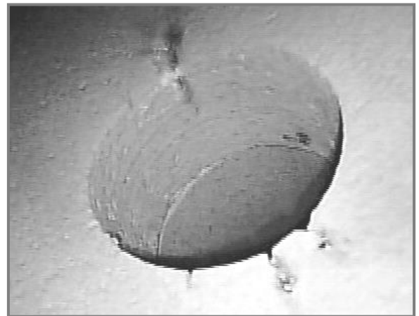
Рис. 2. Радиальное отверстие с трещинами преимущественно расположенными вдоль коллектора.
