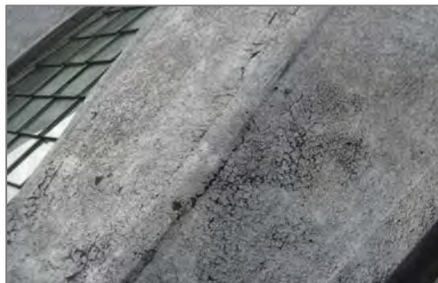
Рис. 8. Повреждения кровельного покрытия
