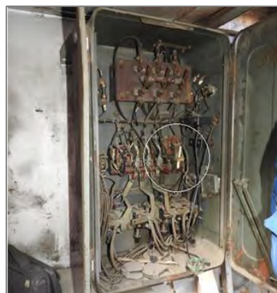
Фото 10. Неисправность главного контактора цепи управления в защитной панели крана.
