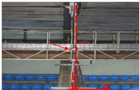
Рис. 3. До 90% стальных арок покрытия имеют погибы вертикальных стяжек и фасонки в узлах крепления.
