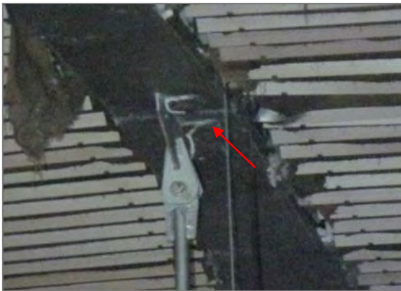
Рис. 4. Усиливающие уголки фасонки имеют деформации и повреждения, сварные швы выполнены некачественно или отсутствуют.
