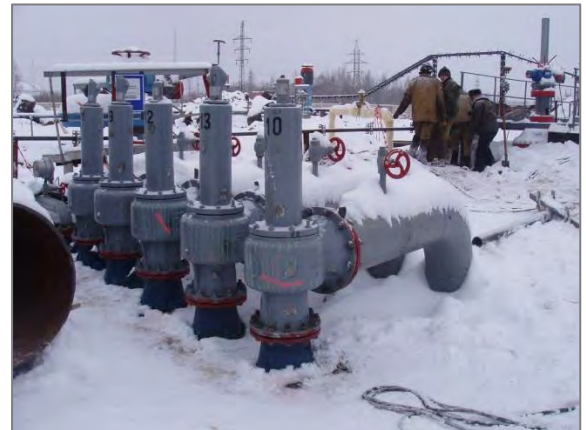
Рис. 10. Внешний вид предохранительных клапанов.
